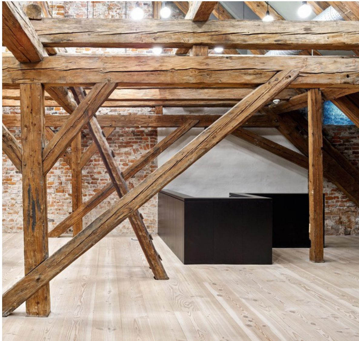
Dakconstructie monument in het zicht
